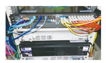
物性研ネットワークの基幹 L3 スイッチ L3 switch: Core network switch of ISSP
