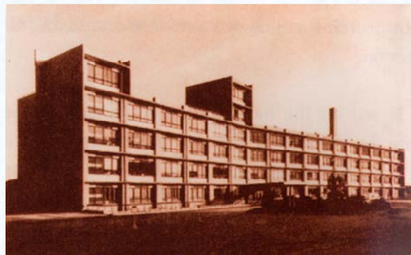
六本木キャンパス物性研究所研究棟（1963年） ISSP Main Building at Roppongi Campus (1963)
