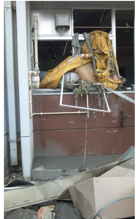
図3. 室内に入り込んだLPガスボンベ
