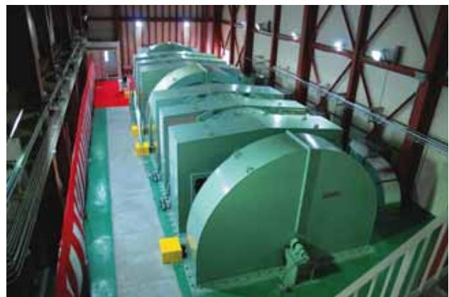
運転開始式を待つ「フライホイール付き直流発電機」の全体写真。円盤状のカバーが手前と中央および奥の3カ所に見られるが、この内部にフライホイールが設置されている。手前と奥には1枚ずつと中央には2枚が収容されており合計4枚のフライホイールが付いている。フライホイール間に見られる矩形の筐体には発電機が収容されている。
