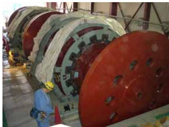
フライホイール発電機の本体。手前に見える赤い円盤がフライホイールで 1 枚の重量が 30 トン。これが全部で 4 枚ある。その向こうの白いシートがかけてある部分がモーター兼発電機部分でこれも 4 台ある。
