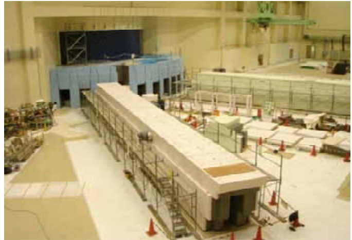
図 10 MLF 第 1 実験ホール（東側）の中性子源周りの装置建設状況。手前は茨城県生命物質構造解析装置（図 9 参照、2007 年 2 月撮影、J-PARC センター提供）。
