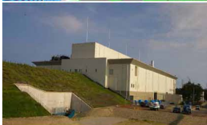
図 8 MLF 実験施設 (上) 装置配置の模式図、中性子とミュオン実験施設が併設する。(下) 建物外観、手前の土手中に 3GeV シンクロトロンからの陽子ビーム輸送ラインがあり上図の右から入射する (J-PARC センター提供)。
