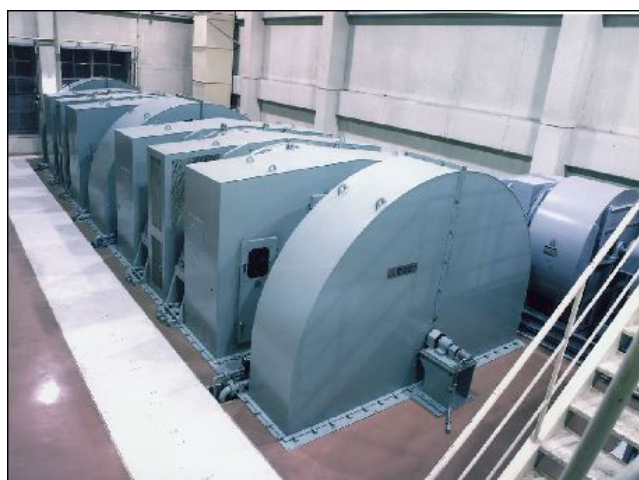
図1 JFT-2M時代のフライホイール付き直流発電機。
