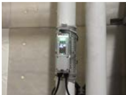
(c) クランプオン式流量計 ※配管を切断せずに取付可能
