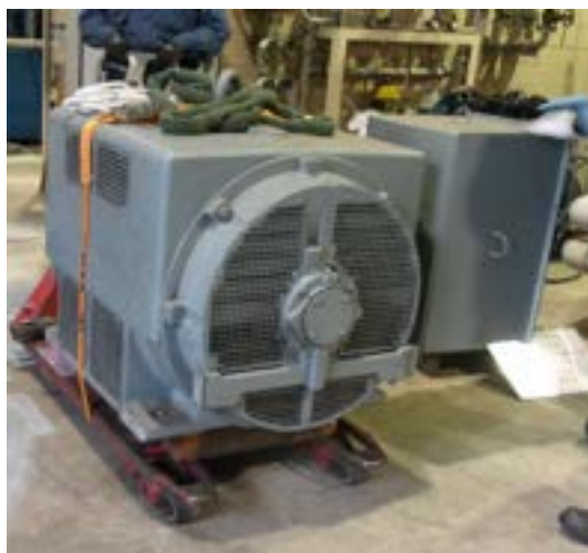
(b) 取り外したモーター
