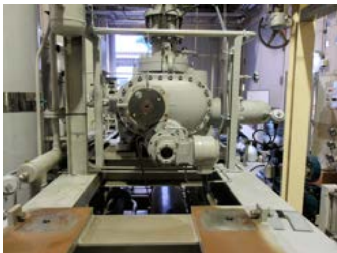
(a) 液化機 No1 用圧縮機 モーター取外後
