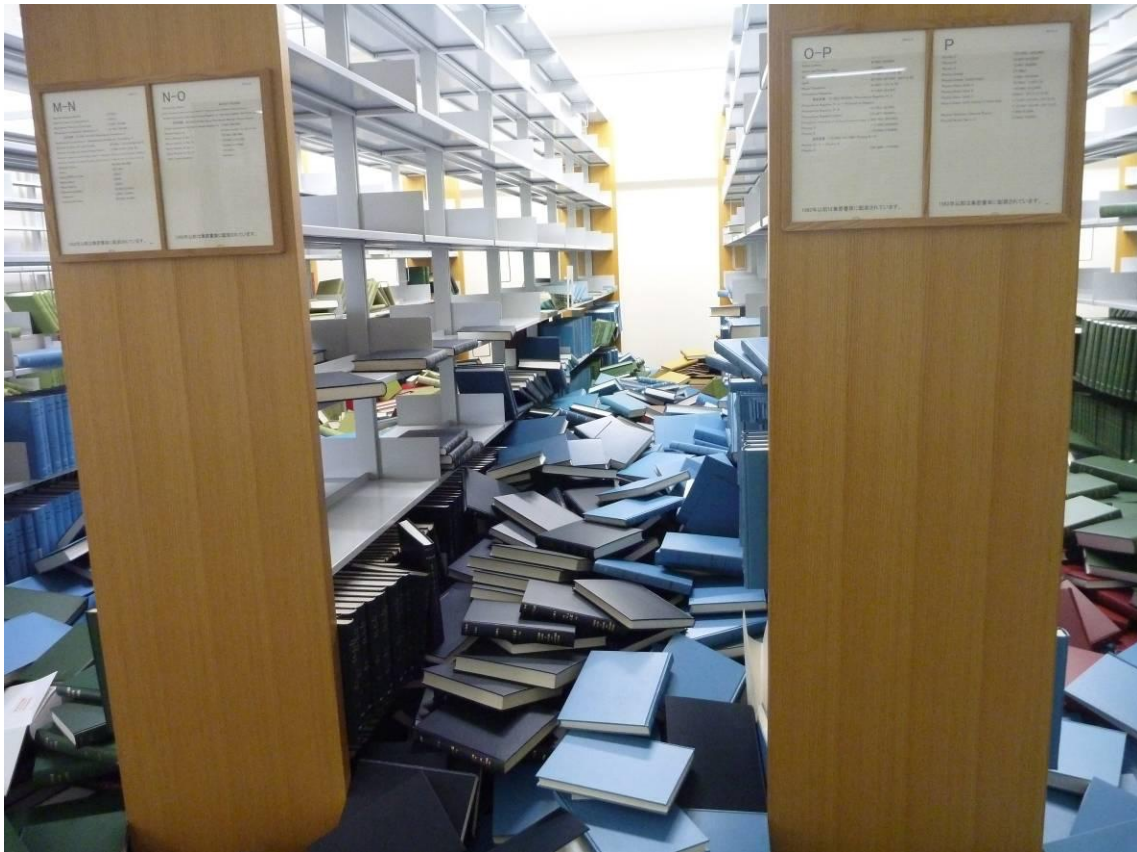
事務用出入口側
