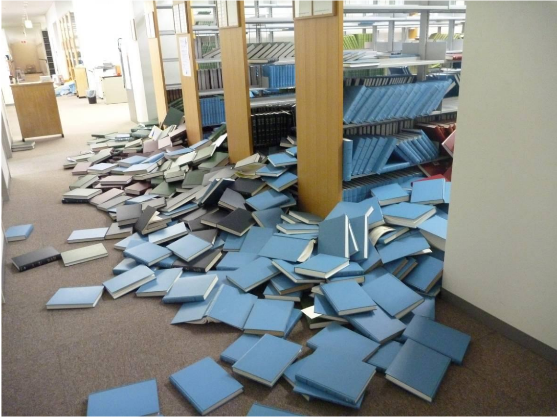
事務用出入口側
