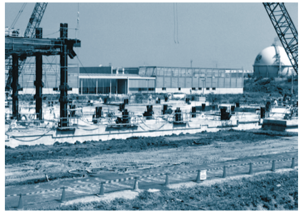
柏キャンパス物性研究所研究棟1階 スラブコンクリート打設完了。
