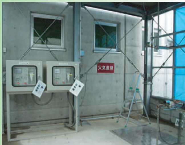
液体窒素自動供給装置
