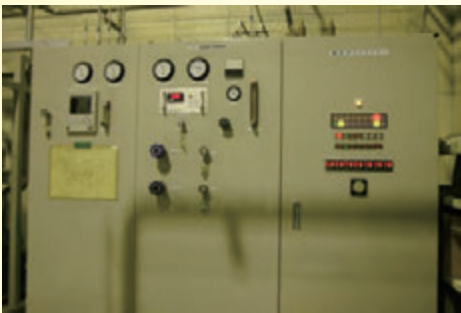
⑥高圧ヘリウムガス乾燥器 小池酸素工業社製 2筒式 12時間切り替え式
