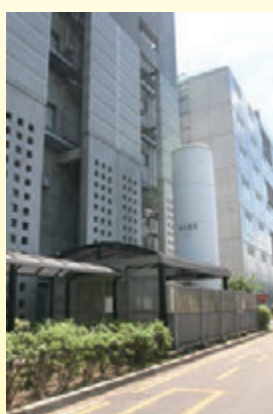
⑭液体窒素貯槽 蒸発率 0.25%/day 20,000L × 4基 (内1基 研究室専用) 10,000L × 1基 (研究室専用)
