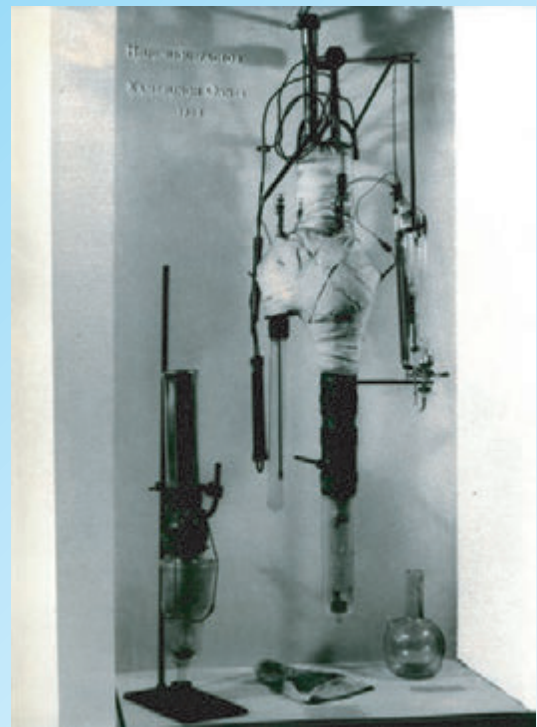
オンネスの世界最初の ヘリウム液化機
