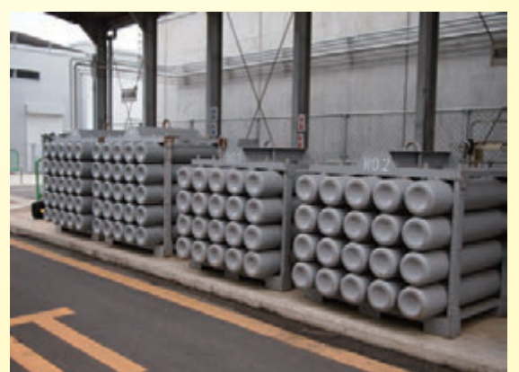
⑮純ガスカードル 140m 3 × 2基、175m 3 × 5基
