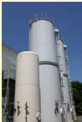
①④回収ガスホルダー 70m 3 × 2基 (中・右) ①⑥, ①⑥-2バッファータンク 16m 3 × 1基 (左) ・ 35m 3 × 1基
