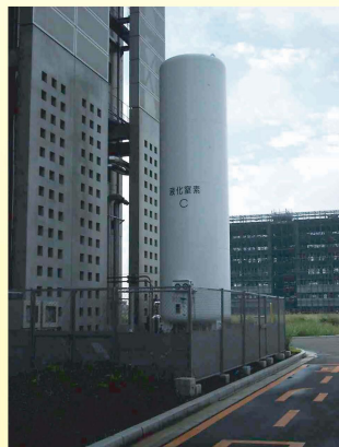
⑭液体窒素貯槽 20,000L (小池酸素) × 3基 蒸発率 0.25%/day
