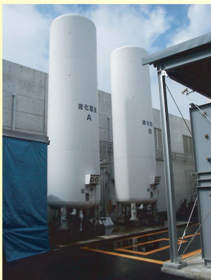
⑭液体窒素貯槽 20,000L (小池酸素) × 3基 蒸発率 0.25%/day
