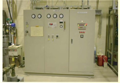
⑧中圧ヘリウムガス乾燥器 小池酸素社製 2筒式 24時間切り替え式
