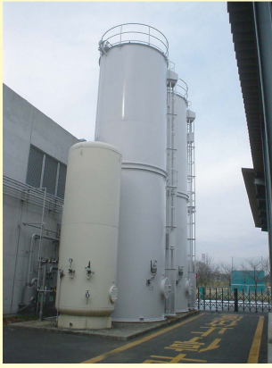
①④回収ガスホルダー 70m 3 ×2基
