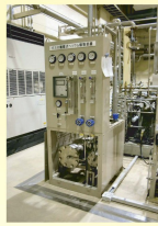
③ヘリウムガス精製器 川崎重工社製 ガス分離膜式 処理能力 144Nm 3 /h
