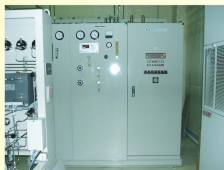
⑥高圧ヘリウムガス乾燥器 小池酸素社製 2筒式 12時間切り替え式
