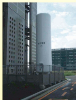
⑭液体窒素貯槽 20,000L(小池酸素) × 3基 蒸発率 0.25%/day
