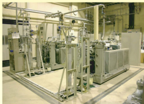
②⑤回収・精製用圧縮機 ブルックハルト社製 190Nm 3 /h×2基
