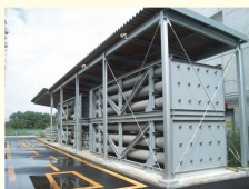
⑦⑧長尺容器 貯蔵能力 4,500Nm 3 A(2,250Nm 3 ), B(1,350Nm 3 ), C(900Nm 3 ) 3系統 切り替え使用可能
