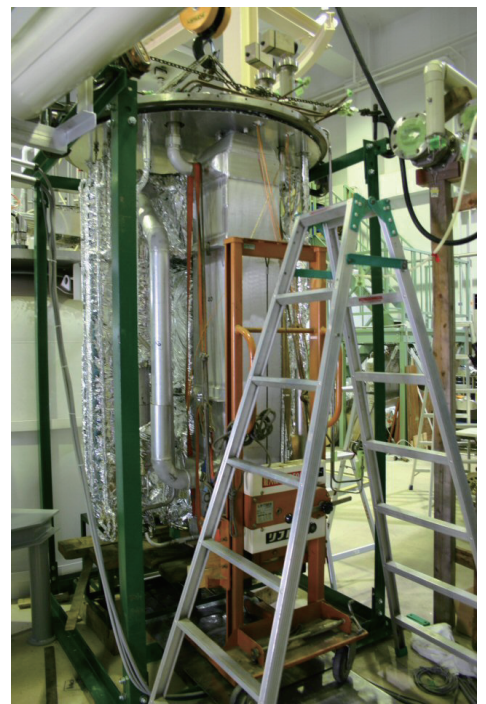
熱交換器修理作業風景
