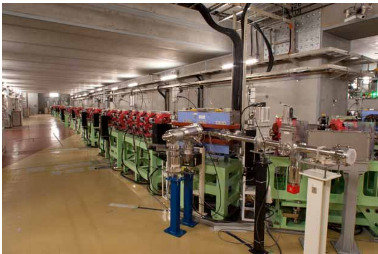
図・1 cERL 配置図（上）と周回部写真（下）2013 年 11 月でマグネットの設置、真空チャンバー据え付け、排気が完了し、周回部ビーム試験を待つ状況。
