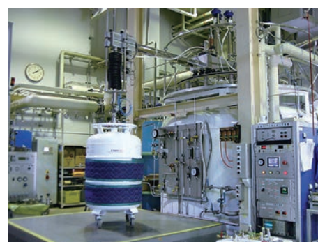
ヘリウム液化機、貯槽及び遠心汲上げポンプ Helium liquefier, storage, and transfer system
