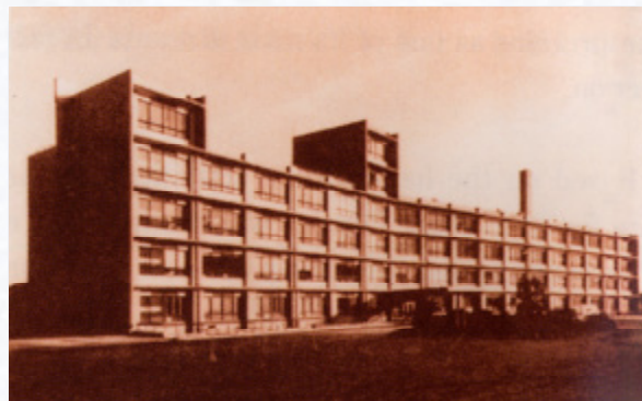
六本木キャンパス物性研究所研究棟（1963年） ISSP Main Building at Roppongi Campus (1963)
