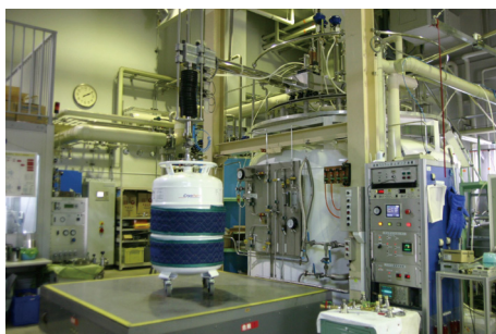
ヘリウム液化機、貯槽および遠心汲上げポンプ Helium liquefier, storage and transfer system
