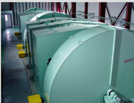
世界最大の直流電源: 回転蓄積エネルギー 210MJのフライホイール発電機。
