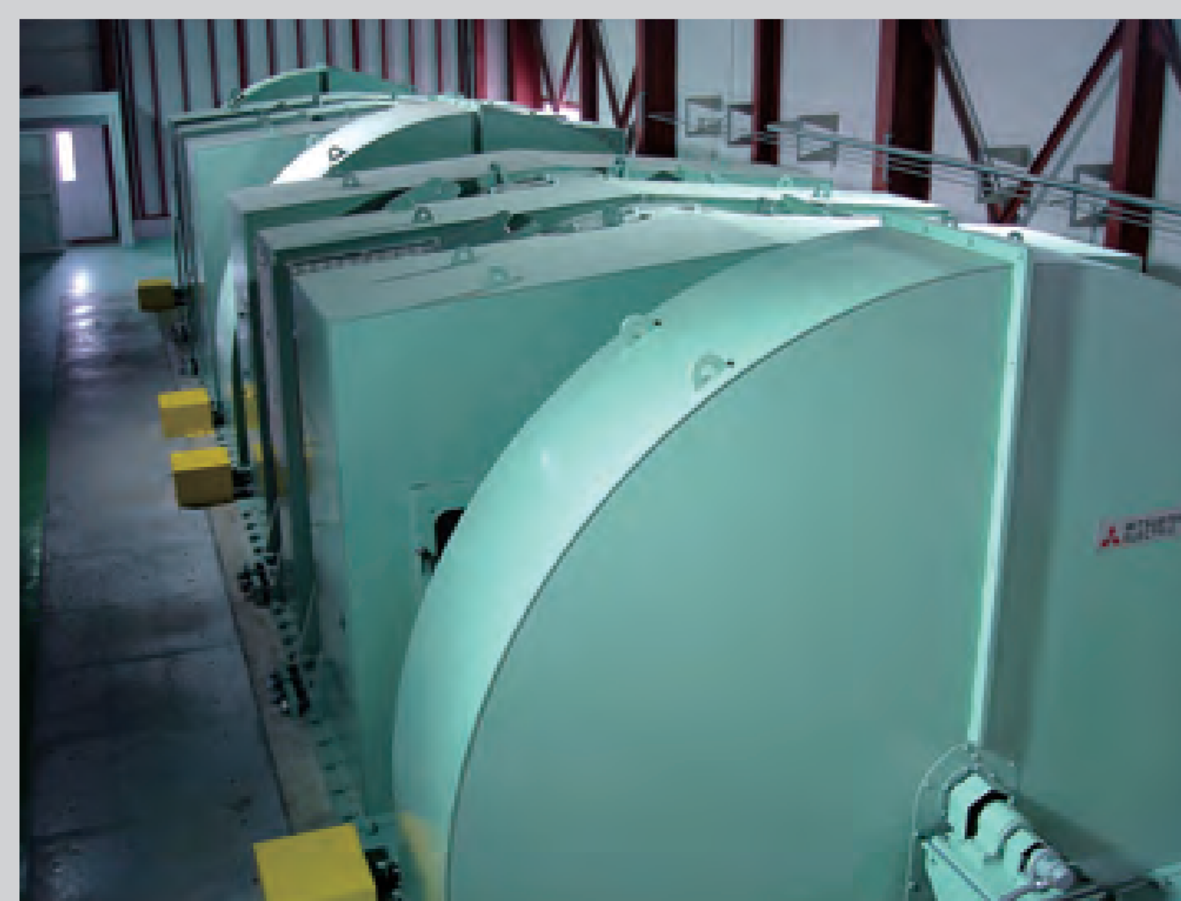
世界最大の直流電源、回転蓄積エネルギー 210MJのフライホイール発電機。 The world's largest DC electric power generator; a flywheel generator capable 210 MJ stored by a rotation energy.
