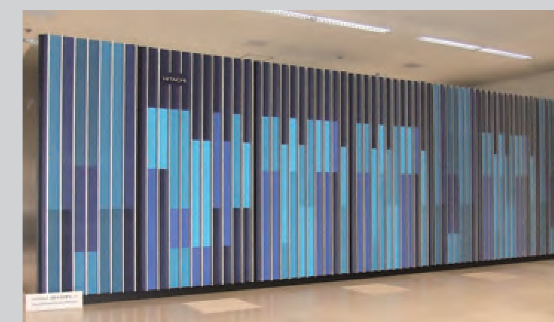
物性研スーパーコンピュータシステムA(sumire)。 ISSP supercomputer System-A(sumire).
