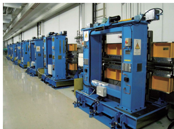
図1 SPring-8 蓄積リング内に設置された8台の水平／垂直偏光型8の字アンジュレータ
