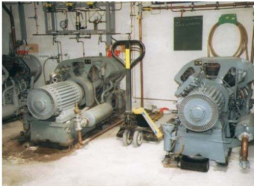
図 33. 回収用圧縮機
