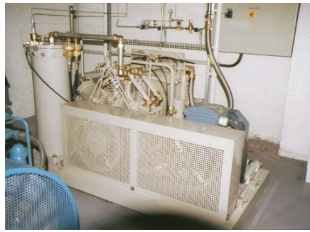
図 11. 回収用コンプレッサー
