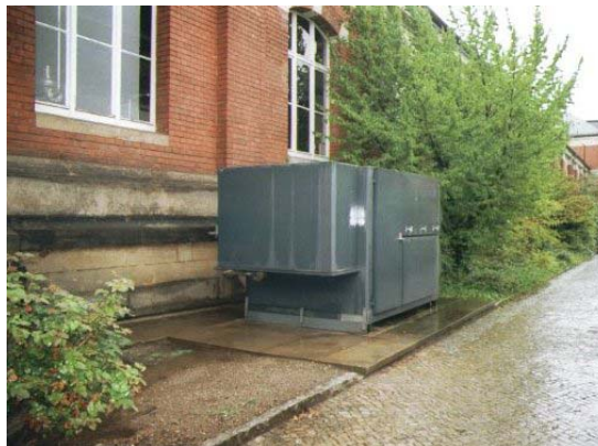
図 25. 屋外に設置されている圧縮機
