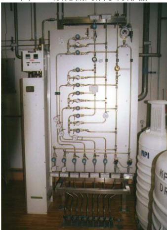
図 13. ガスハンドリングパネル
