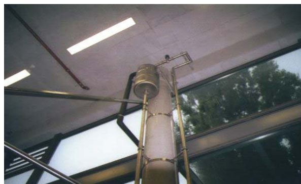
図3. 液体窒素供給装置上部にある気液分離器
