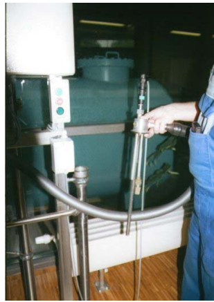
図 8. 液体窒素自動供給装置
