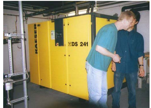
図 15. 液化機用圧縮機
