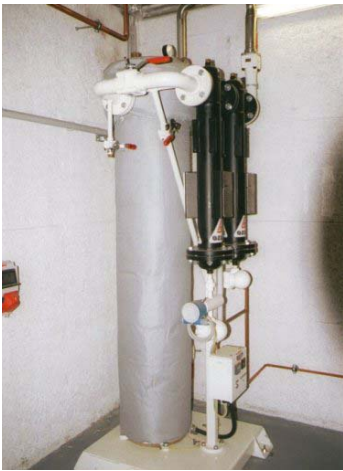
図 10. 液化機用油水分離器
