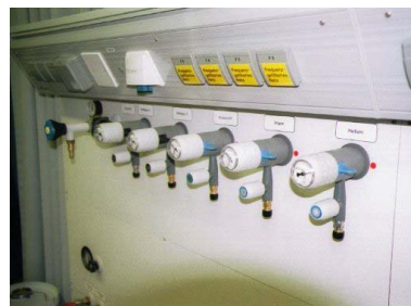
図 20. 各種ガス配管
