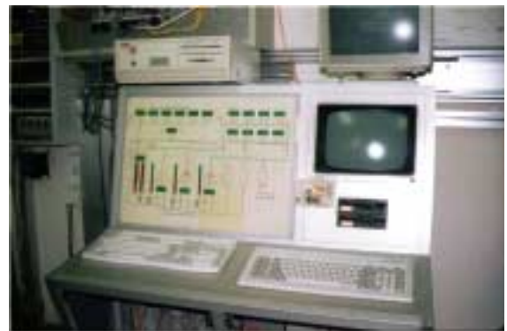
図12 液化システムのコントロールパネル
