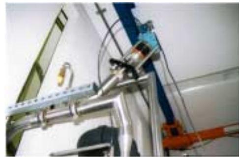
図5 液化機内部に入る窒素配管にバルブ
