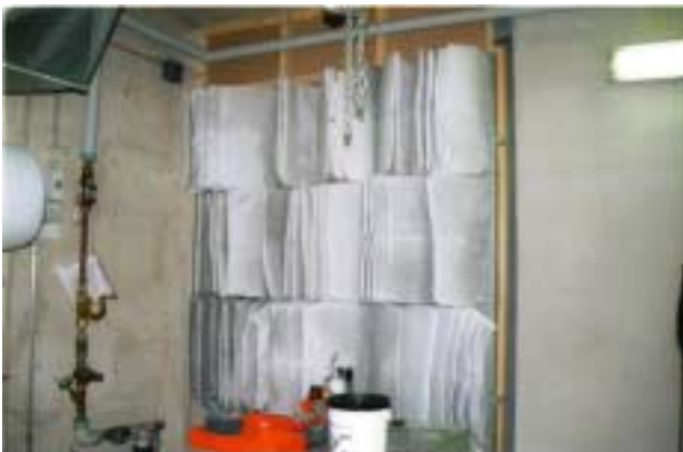
図 1 4 窒素液化機用圧縮機の空気の取り込み口
