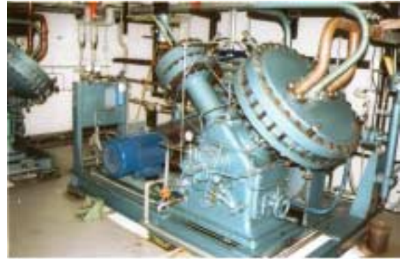
図11 回収用圧縮機（ダイヤフラム式）
