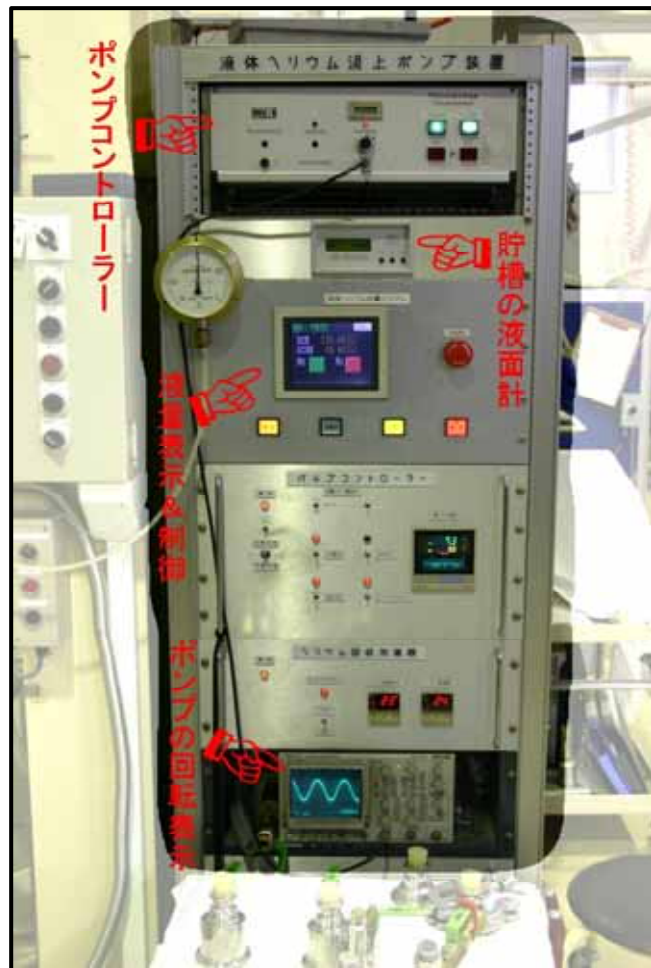
図2 汲み出し制御装置
