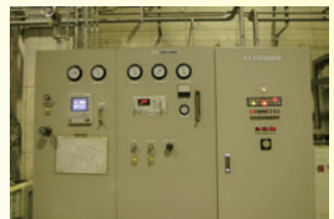
⑧中圧ヘリウムガス乾燥器 小池酸素工業社製 2筒式 24時間切り替え式
