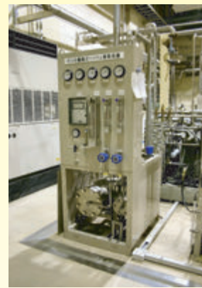
③ヘリウムガス精製器 川崎重工社製 ガス分離膜式 処理能力 144Nm 3 /h
