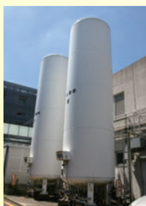
⑭液体窒素貯槽 蒸発率 0.25%/day 20,000L × 4基 (内1基 研究室専用) 10,000L × 1基 (研究室専用)
