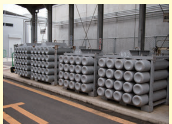
⑮純ガスカードル 140m 3 × 2基、175m 3 × 5基
