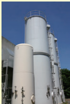
①④回収ガスホルダー 70m 3 × 2基 (中・右)
