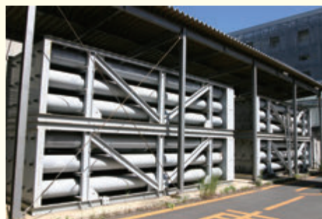
⑦長尺容器 貯蔵能力 11,250Nm 3 A (2,250Nm 3 ), B (1,350Nm 3 ), C (900Nm 3 ) D (3,375Nm 3 ), E (3,375Nm 3 ) 5系統 切替使用可
