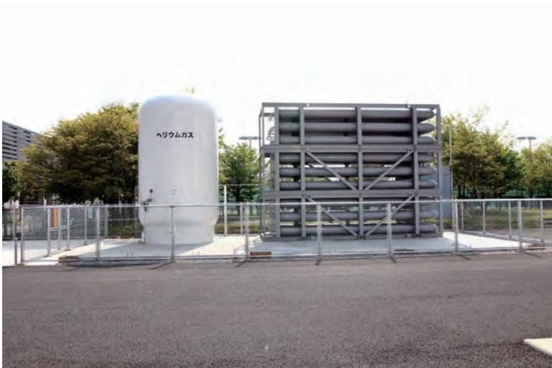
図2 長尺カードルの設置状況
